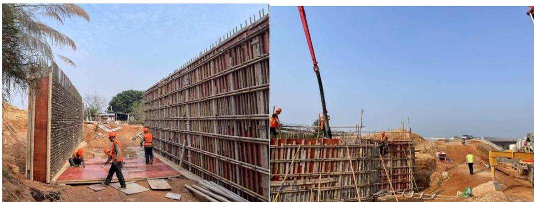
图 1-1 项目箱涵施工照片
